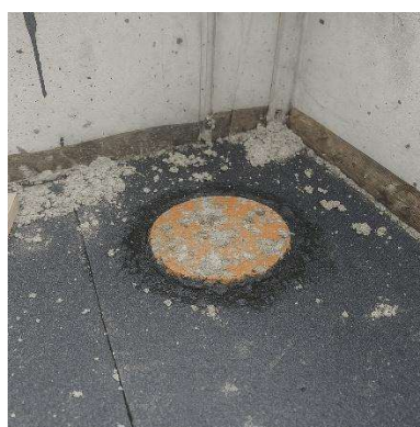
Figura 2 Sigillatura con composto impermeabilizzante per un raccordo di tubo a filo con la soletta
