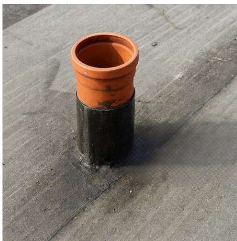
Figura 3 Sollevamento del bitume sul passaggio del tubo
